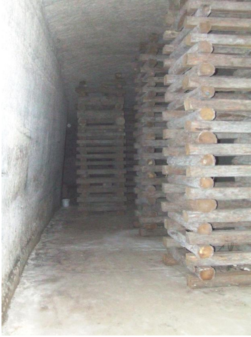
Máglyasor és a főte alátámasztása a máglyával
