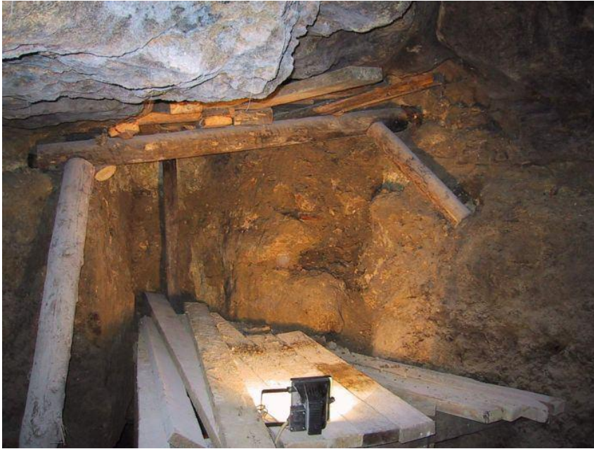
Feltárvágat indítása hézagos tűzéssel (Budai Vár)
